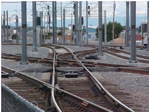
Figura 2—Acima, cruzamento dos trilhos das vias dos trens elétricos urbanos do RTD de Denver na Estação Broadway. O sistema LRT de Denver terá um total de 120 milhas de vias quando o projeto for concluído em 2016.
