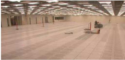
Figura 2—Sala de computação com 24.000 pés quadrados de área livre com piso elevado de 48 polegadas. Os equipamentos desta sala têm capacidade de desempenho de pico acima de 100 tera-FLOPS.
