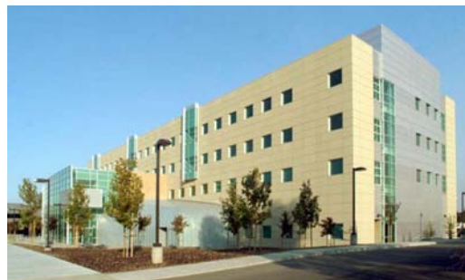
Figura 1—Sede do TSF com um total de 48.000 pés quadrados de área computacional, com uma carga prevista de 23 MW. O edifício requer alimentação de energia elétrica confiável para evitar a interrupção dos computadores.
