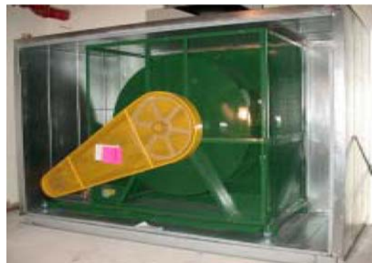
Unidade de Ventilação de Ar de 80.000-ft 3 /min
