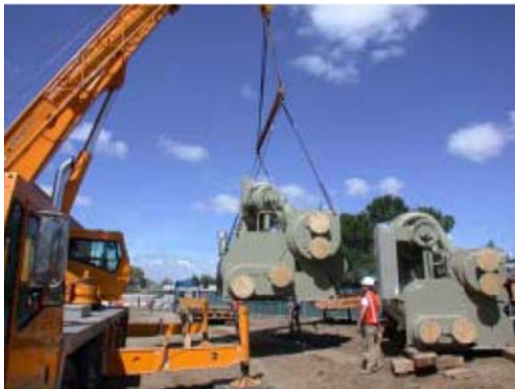
Instalação da Unidade de Resfriamento
