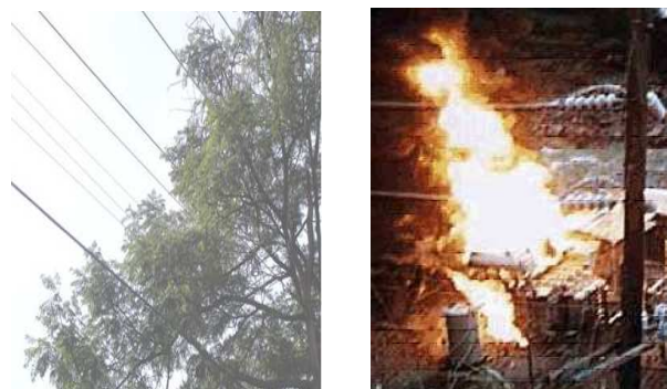
Fig.5. Árvores próximas à rede e transformador após explosão
